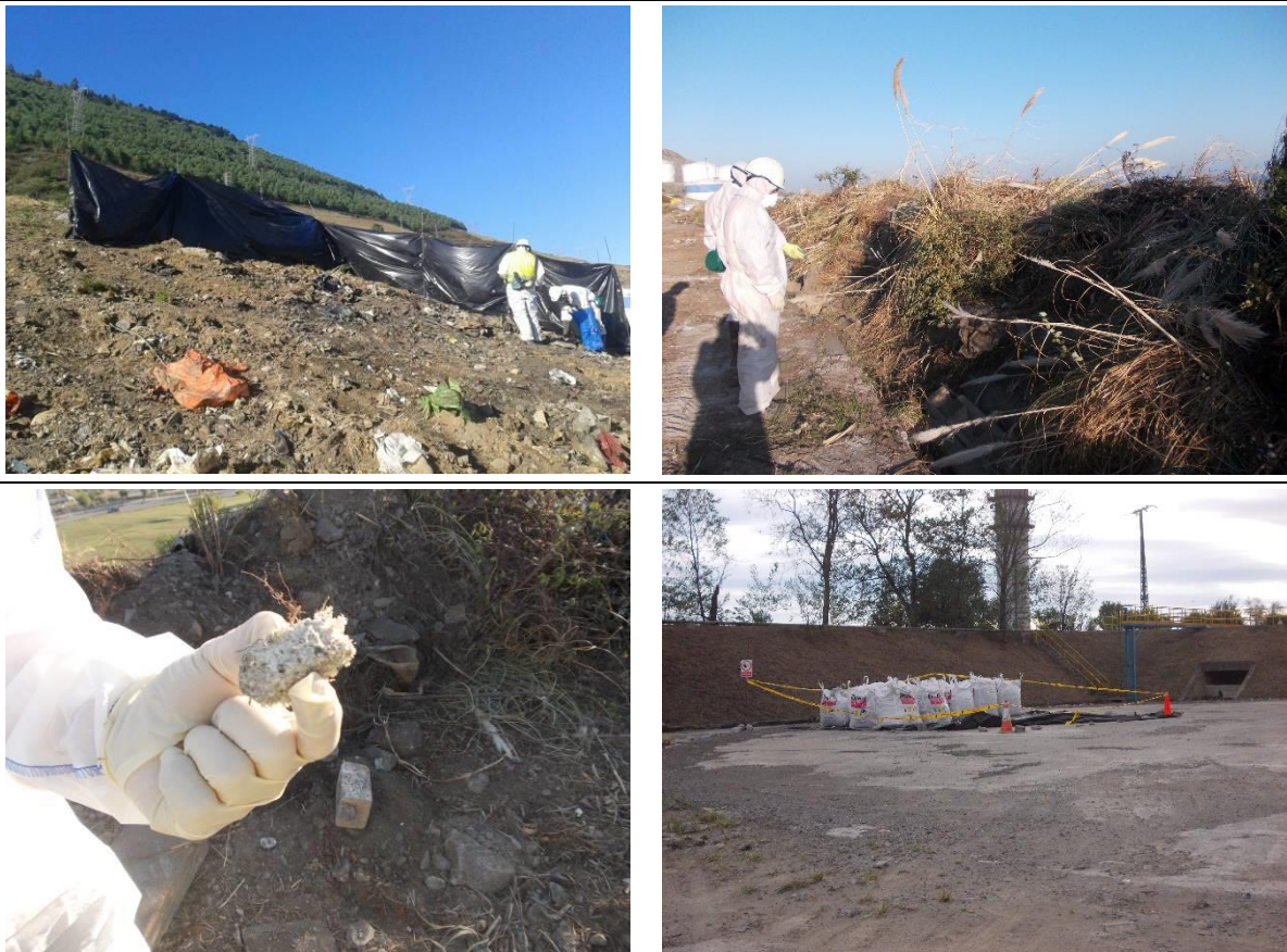
Figura 9. Recogida manual de amianto
