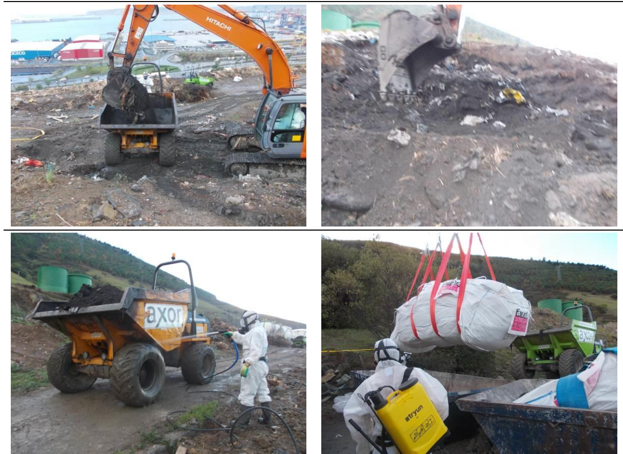
Figura 10. Excavación selectiva de tierras con amianto
