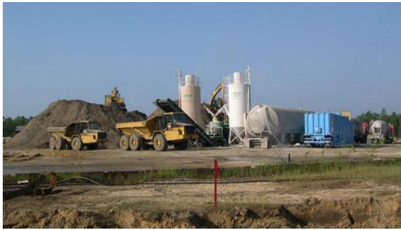
Figura 11. Solidificación/estabilización on site e in situ
