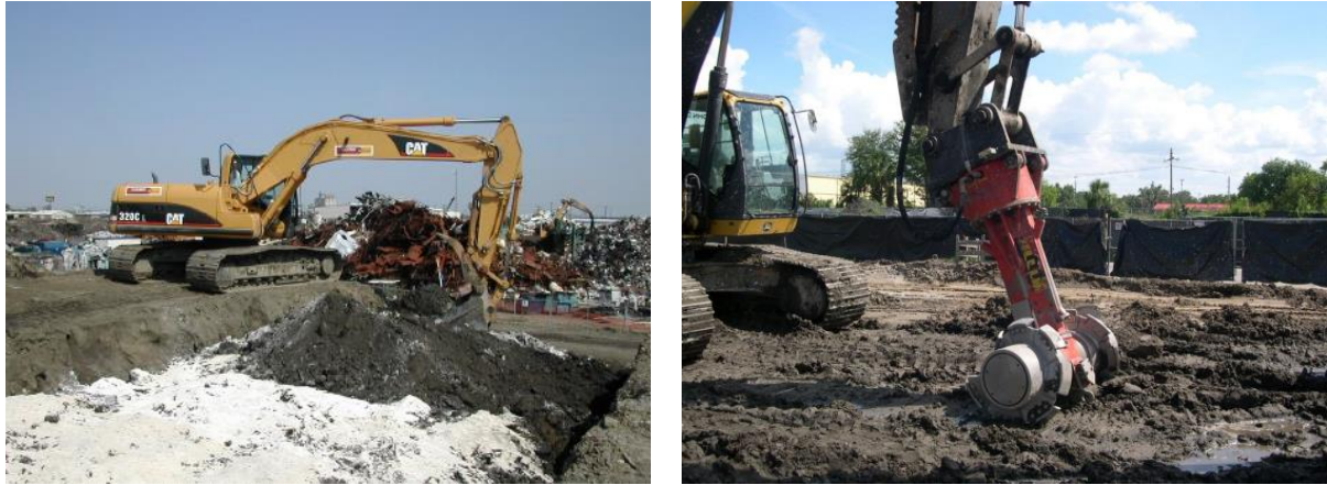
Figura 11. Solidificación/estabilización on site e in situ
