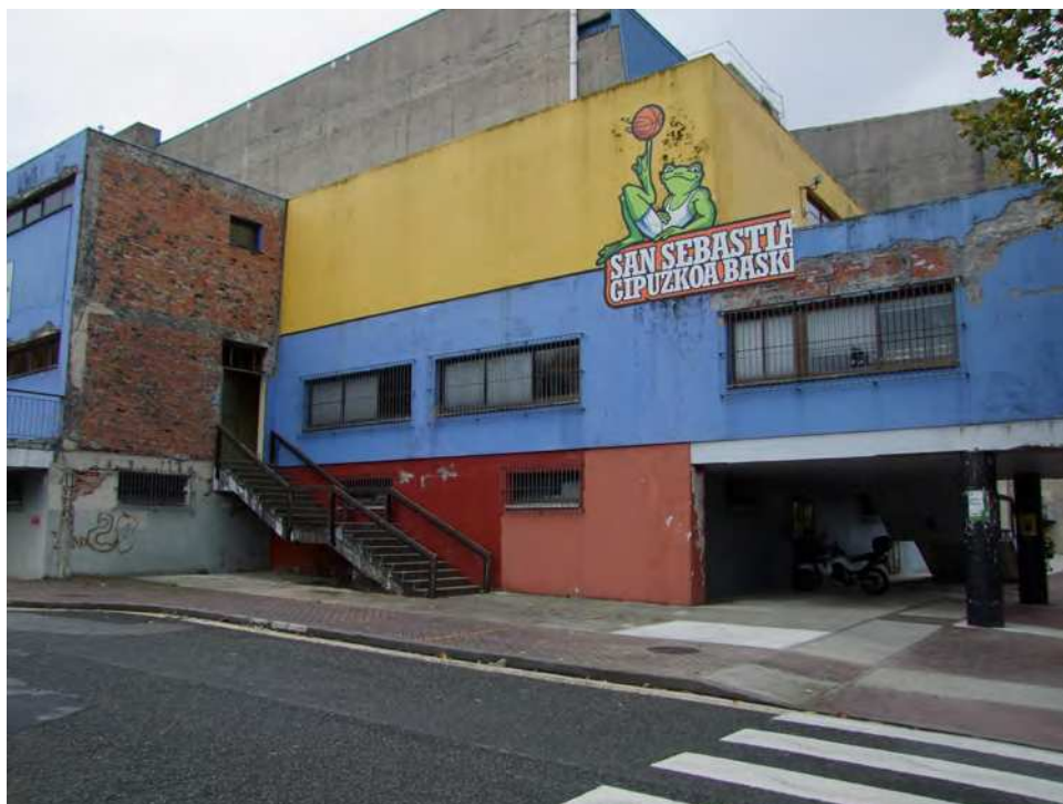
Fachada Noroeste hacia el soportal
