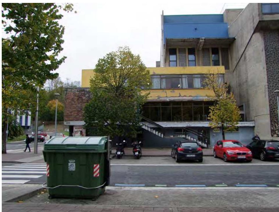
Fachada Sureste y vista de la escalera de acceso
