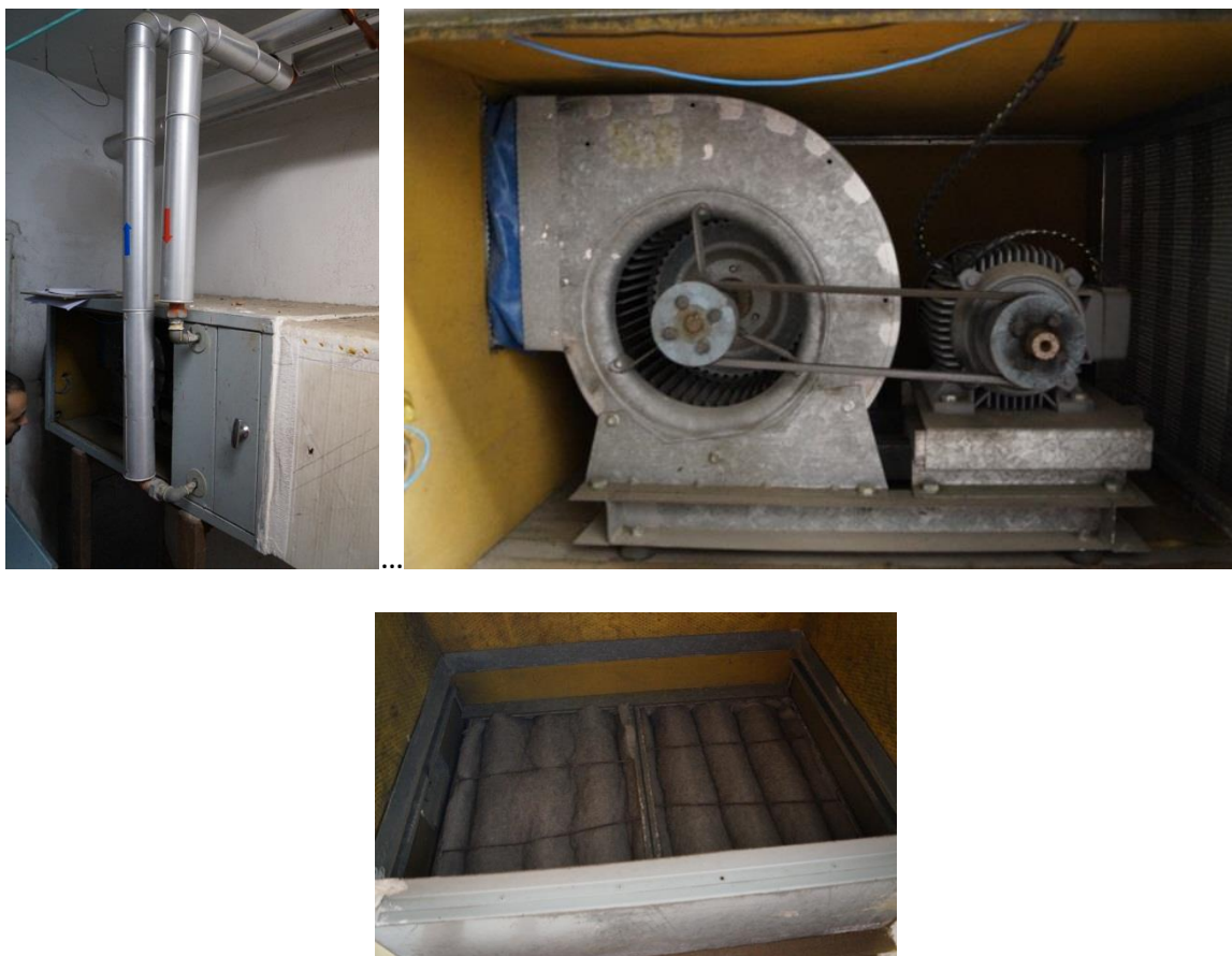
Filtro de la climatizadora
