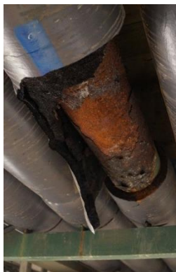
falta de calorifugado
