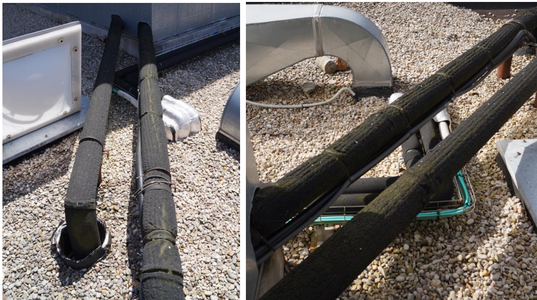
Corrosión en elementos de la sala de la enfriadora en cubierta
