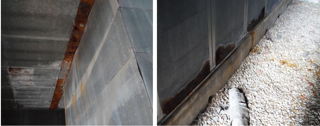
Corrosión en elementos de la sala de la enfriadora en cubierta
