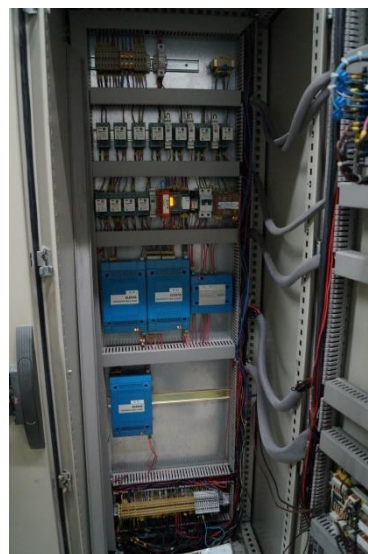
Cuadro de control y maniobra del grupo cogenerador
