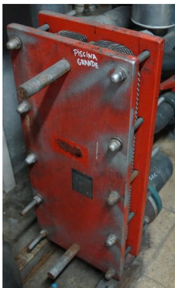
Intercambiador piscina grande..... ....Bombas de impulsión circuito se
