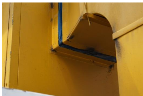
Desperfectos en los elementos de la climatizadora.
