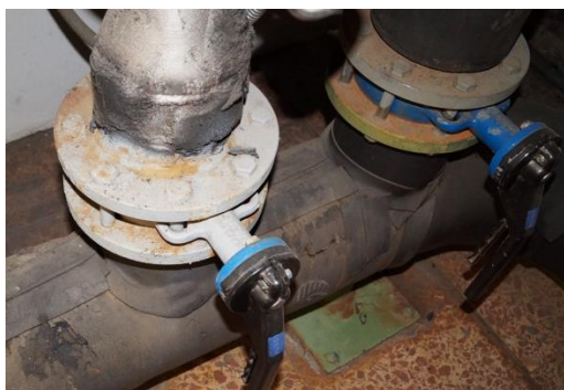
Elementos de unión en mal estado
