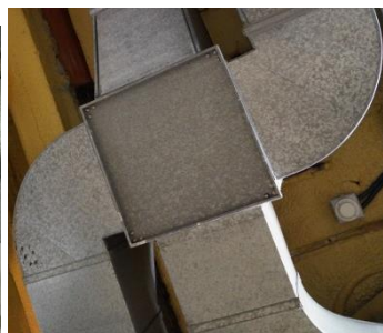
Recuperador de calor
