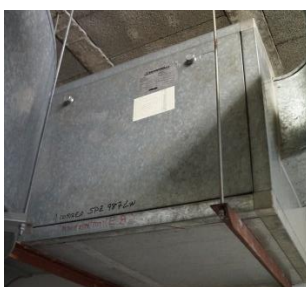
Ventilador de impulsión
