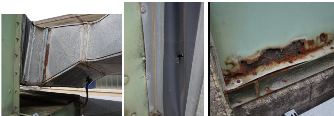
Desperfectos en los elementos de la climatizadora.
