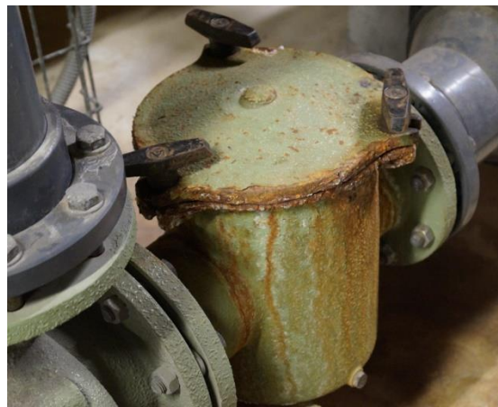
Filtro de pelos a sustituir
