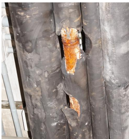
Falta de calorifugado en tuberías
