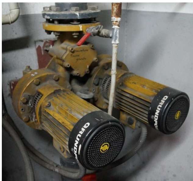
Intercambiador piscina grande..... ....Bombas de impulsión circuito se
