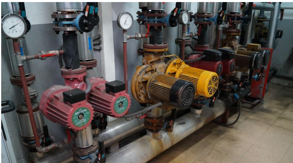
Bombas de impulsión circuitos del colector principal de generación de calor
