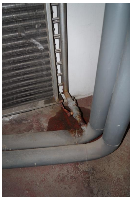
Fuga en la llave del circuito de la batería de calor
