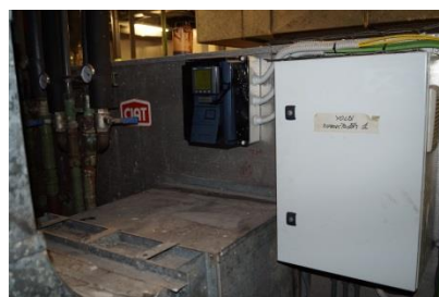
Contador de energía y variador frecuencia
