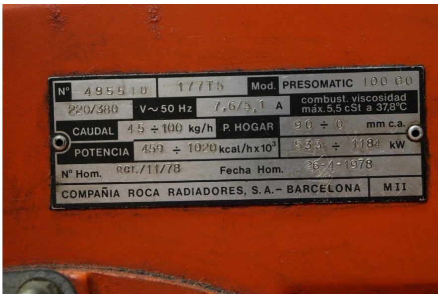
Datos del quemador ROCA PRESOMATIC 100 G0
