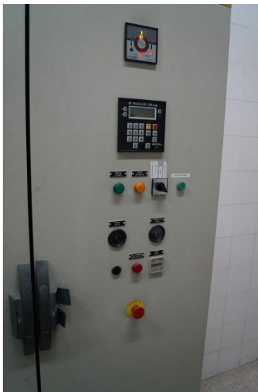
Cuadro de control y maniobra del grupo cogenerador
