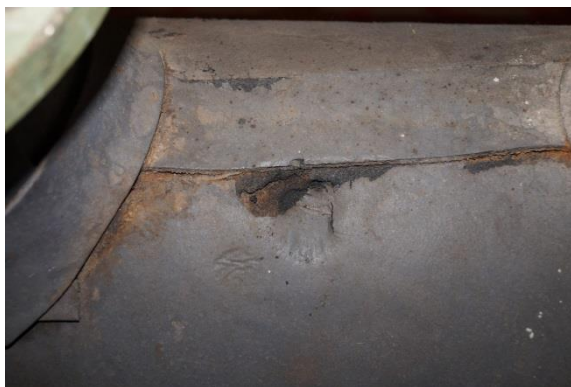
Pérdida de características mecánicas del calorifugado
