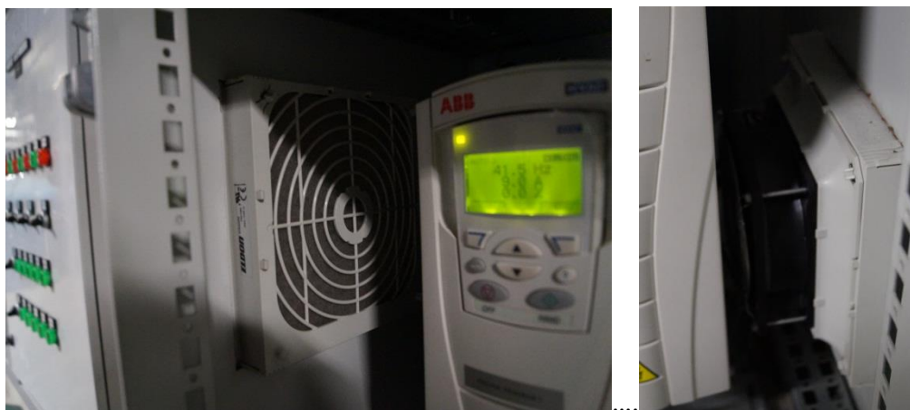
Rejilla de entrada y extracción forzada.
