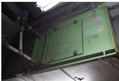
Climatizadora con batería de calor
