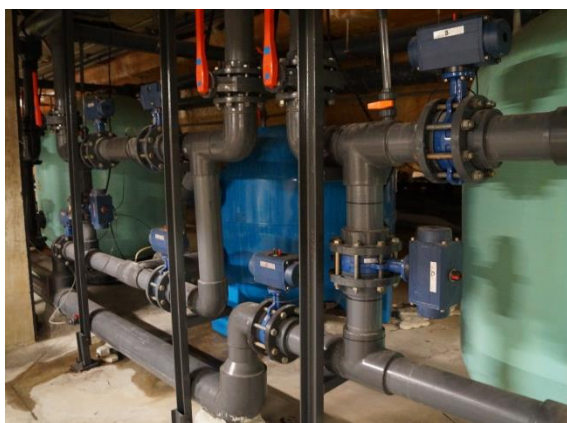
Filtros de arena, 1 y 3 a sustituir
