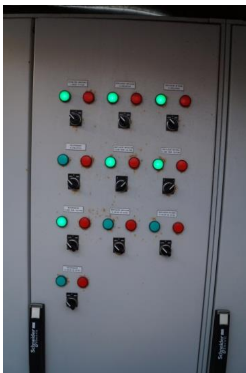
Cuadro control de las climatizadoras en planta 1ª
